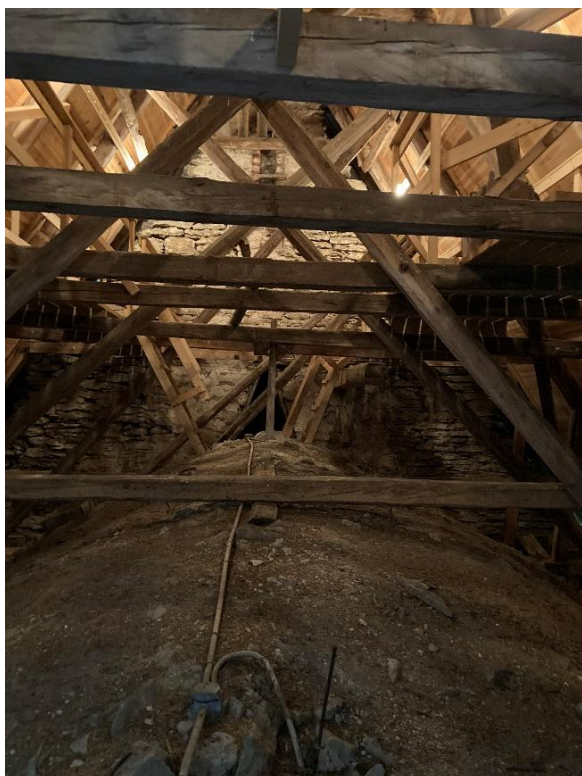
Långhusvinden mot öster med valvens ovansida respektive takstolens övre del. Foto JL 2023.
