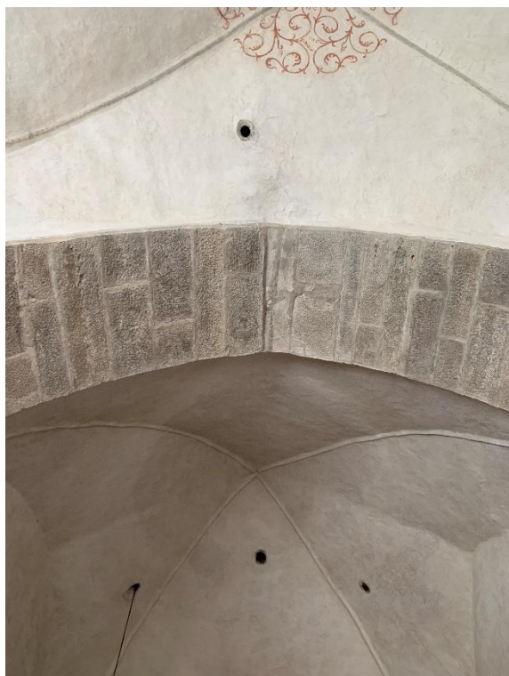
Tornbågen sedd underifrån, öster uppåt i bild, med hål för klocklina i västra långhusvalvet från tidigare torn eller takryttare, samt hål i tornvalvet. Till höger tornvalvet. Foto JL 2023.
