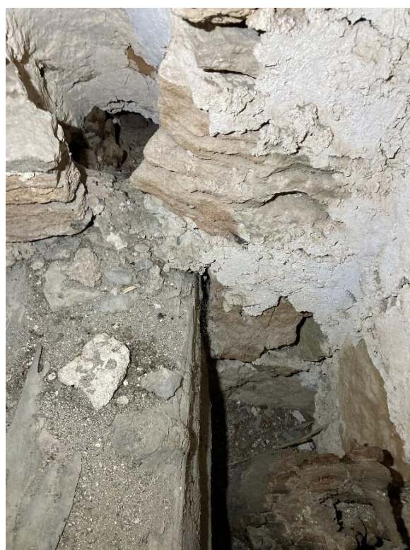
Del av avlastningsbågens träkonstruktion. Till höger tvärbjälke nära östra tornmuren med rörformat hål i muren samt nedan rester av sturk, sett mot norr. Foto JL 2023.
