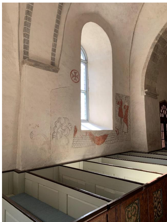
Västra delen av långhusets södra mur med murförtjockning för det planerade tornet samt spår av tidigare portal och målningar från 1500-talet. Till höger långhusets valv mot sydöst. Foto JL 2023.
