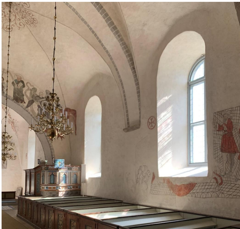
Långhusets södra mur mot sydöst. Foto JL 2023.
