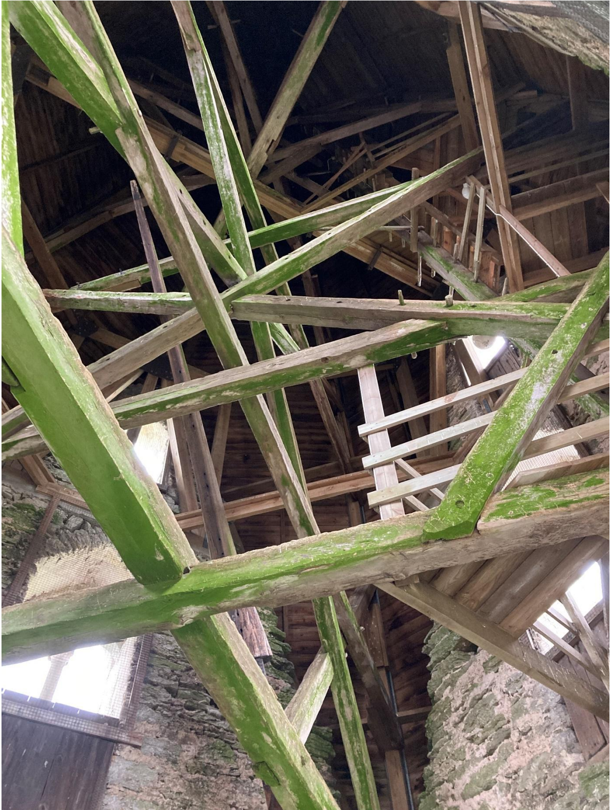
Huvkonstruktionen sedd underifrån. Foto JL 2023.
