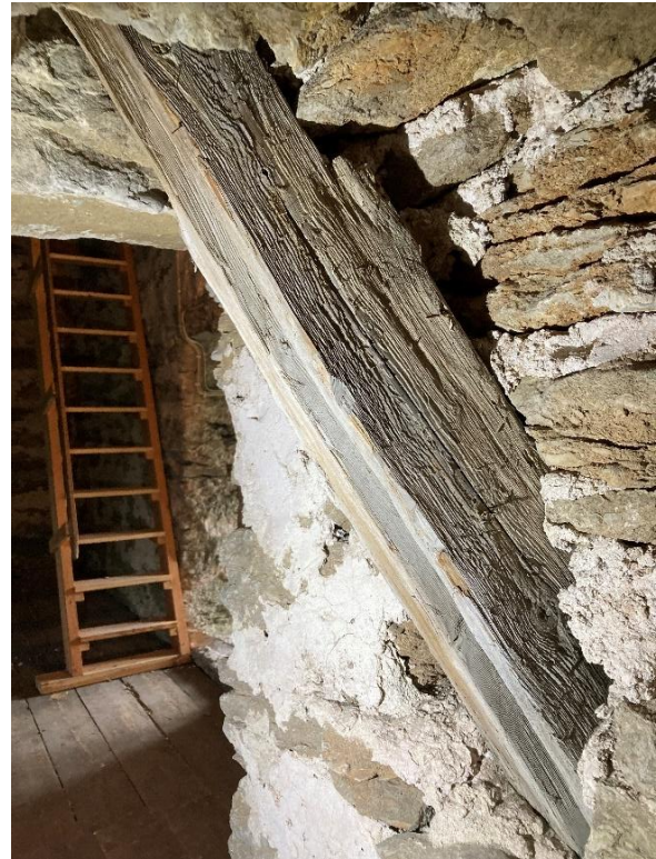
Passage till långhusvinden från tornets första övervåning genom östra tornmuren med inmurat återanvänt urskårat trästycke. Foto JL 2023.
