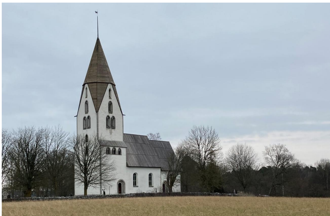
Exteriör från sydväst. Foto JL 2023.
