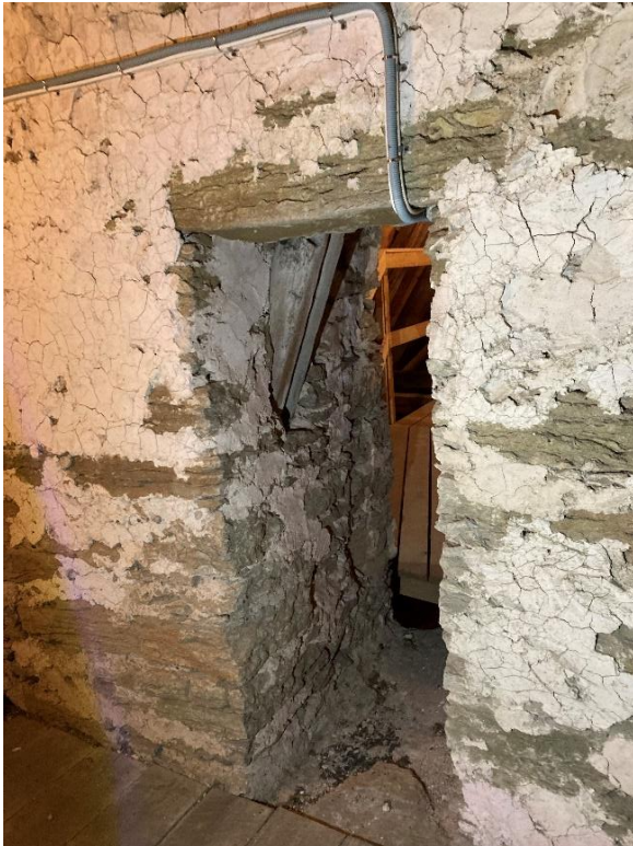
Passage till långhusvinden från tornets första övervåning genom östra tornmuren med inmurat återanvänt urskårat trästycke. Foto JL 2023.
