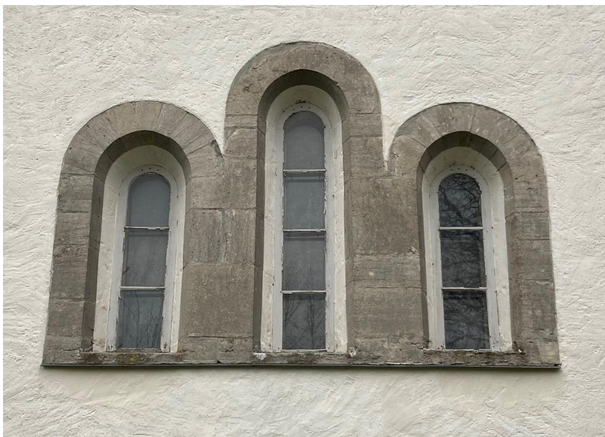
Korgaveln från öster. Ovan änden av en ankarbälke i gavelröset. Nedan trefönstergruppen. Det mellersta fönstret kröns av en båge huggen i ett stenblock medan sidofönstren har bågar av flera stenar. Foto JL 2023 samt (ovan) Pär Malmros 2022, Visby stift.
