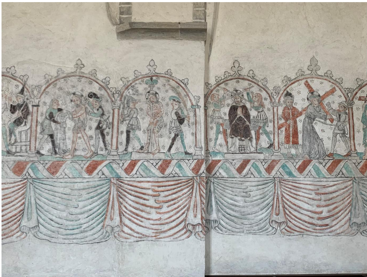
Kalkmålningar på långhusets norra mur samt murklack för att bredda muren under det planerade tornet. Foto JL 2023.
