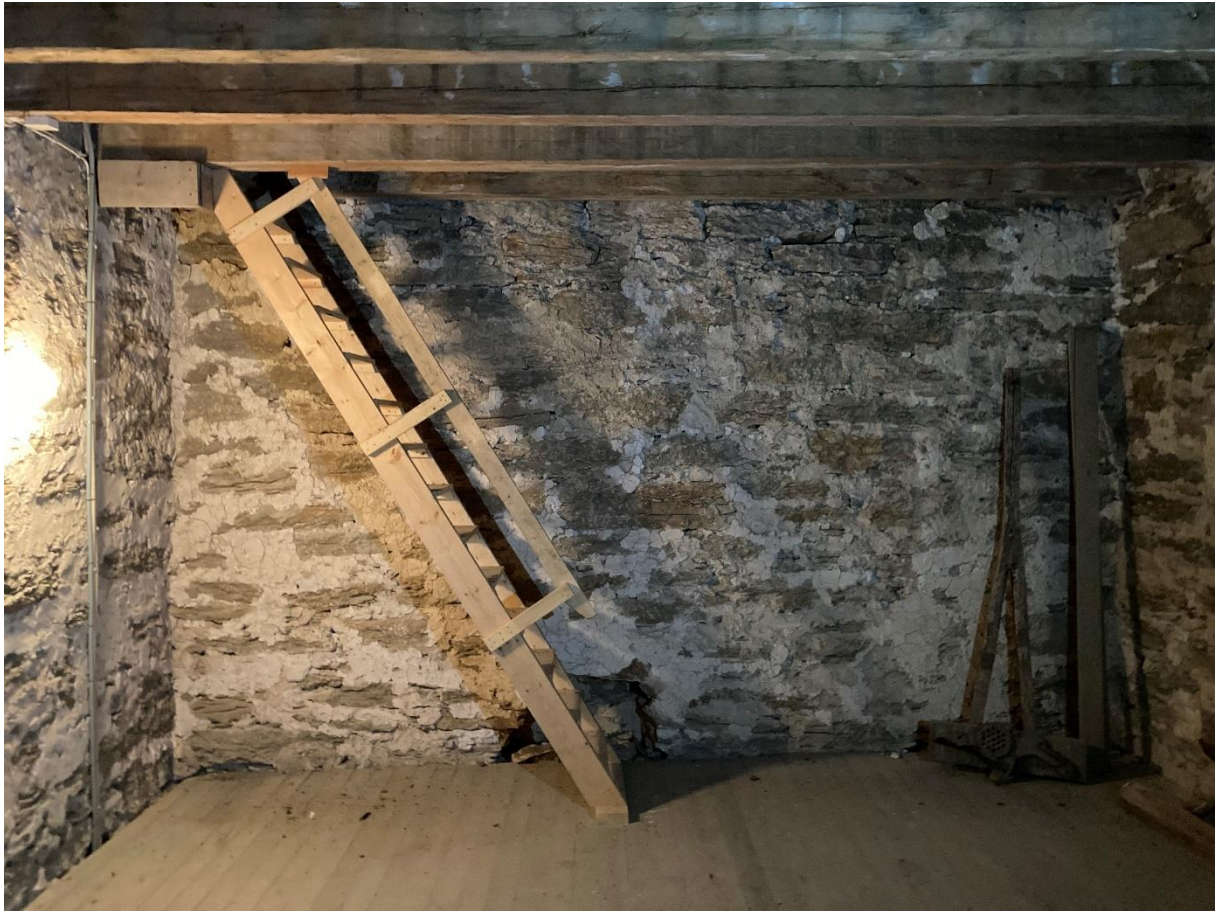
Tornets andra övervåning mot öster. Foto JL 2023.
