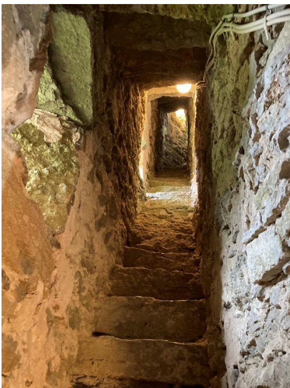
Murtrappa i tornets västra mur sedd uppåt mot norr samt nedåt mot söder. Foto JL 2023.
