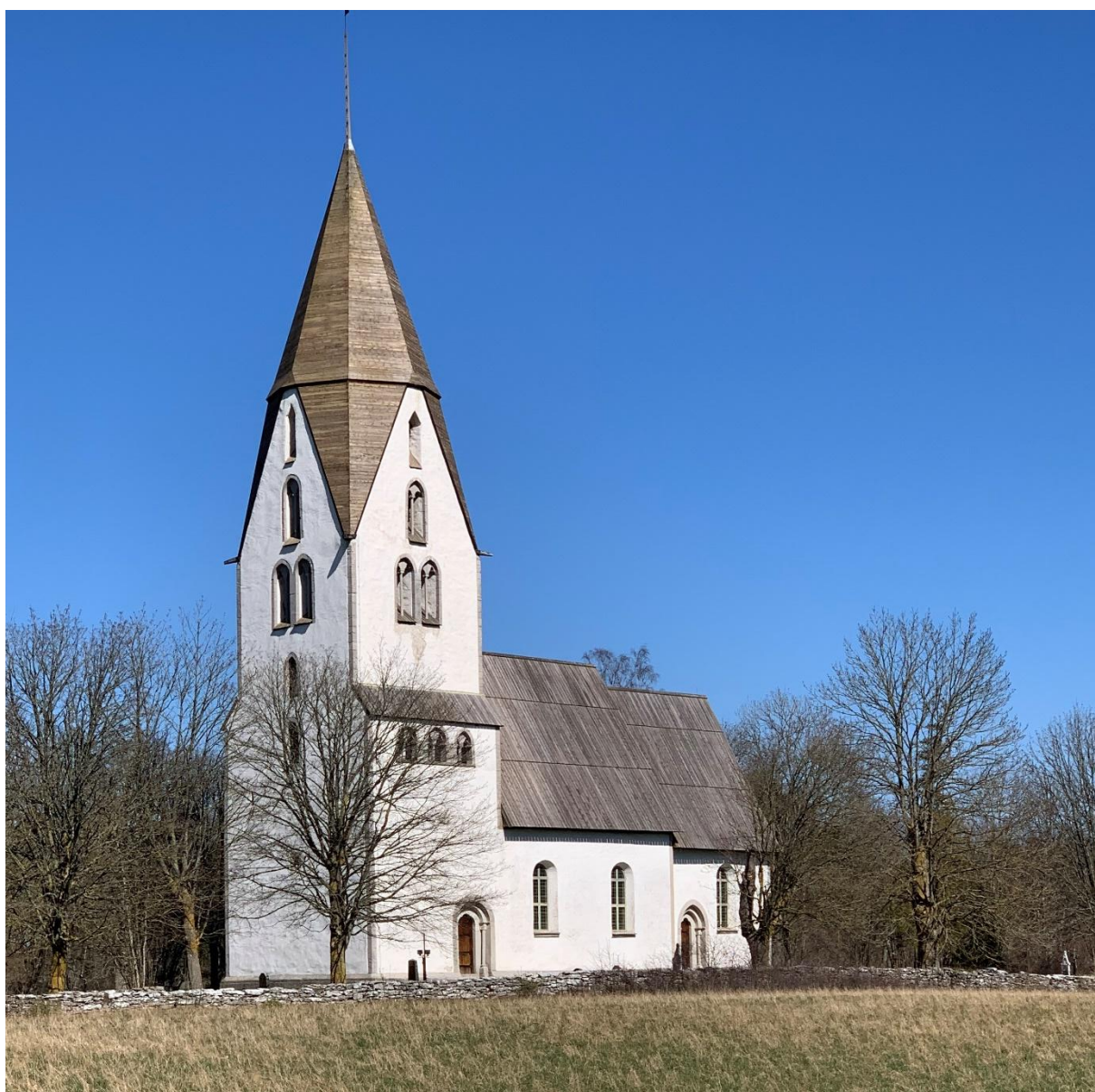
Exteriör från sydväst. Foto JL 2023.
