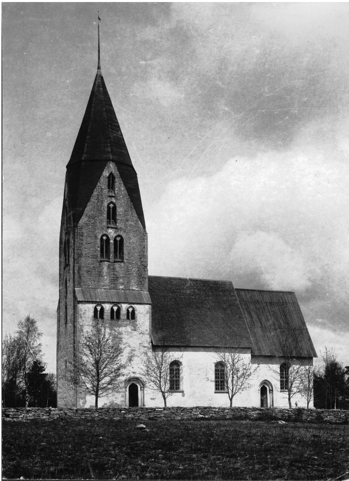
Exteriör från söder vid 1800-talets slut. Vid en restaurering på 1860-talet togs ett nytt fönster upp och övriga förstörades, långhustaket fick spån och sänktes troligen något. Foto ATA.
