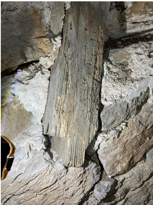
Inmurade återanvända trästycken i tornet östmur, sedda inifrån långhusvinden.
