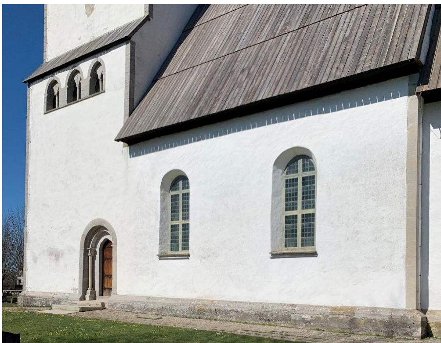
Långhusets sydfasad. Foto JL 2023.
