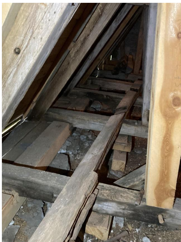
Långhusvindens västra del mot söder längs tornets östmur och mot väster längs långhusets södra mur. Inga synliga rester finns av en tidigare tornuppbyggnad över långhusets västra del vilket talar för att planen aldrig fullföljdes innan det nuvarande tornet byggdes. Foto JL 2023.
