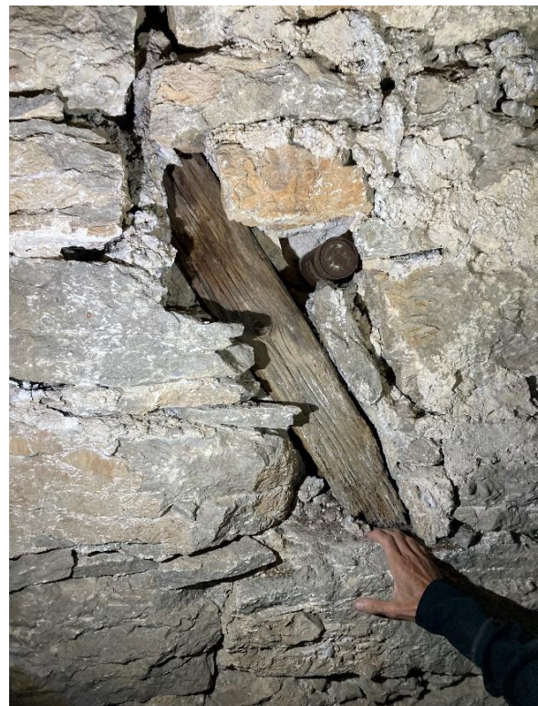
Inmurade återanvända trästycken i tornet östmur, sedda inifrån långhusvinden.
