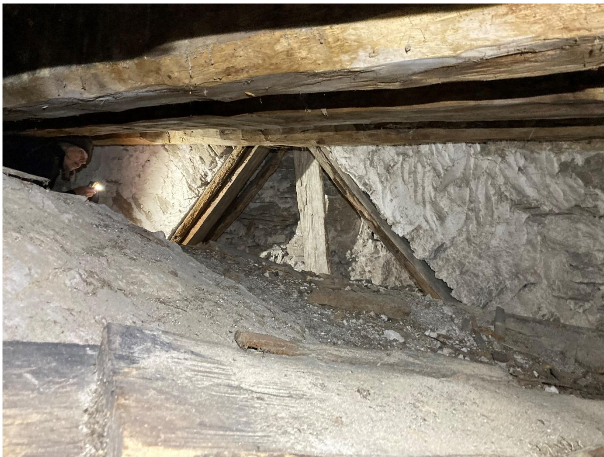
Utrymme mellan tornvalvet och första övervåningens golv, sett mot öster med avlastningsbåge ovanför tornbågen. Foto JL 2023.
