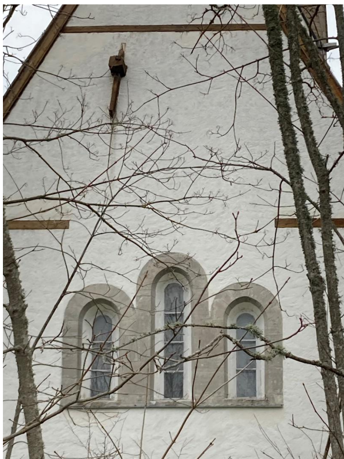
Korgaveln från öster. Ovan änden av en ankarbälke i gavelröset. Nedan trefönstergruppen. Det mellersta fönstret kröns av en båge huggen i ett stenblock medan sidofönstren har bågar av flera stenar. Foto JL 2023 samt (ovan) Pär Malmros 2022, Visby stift.
