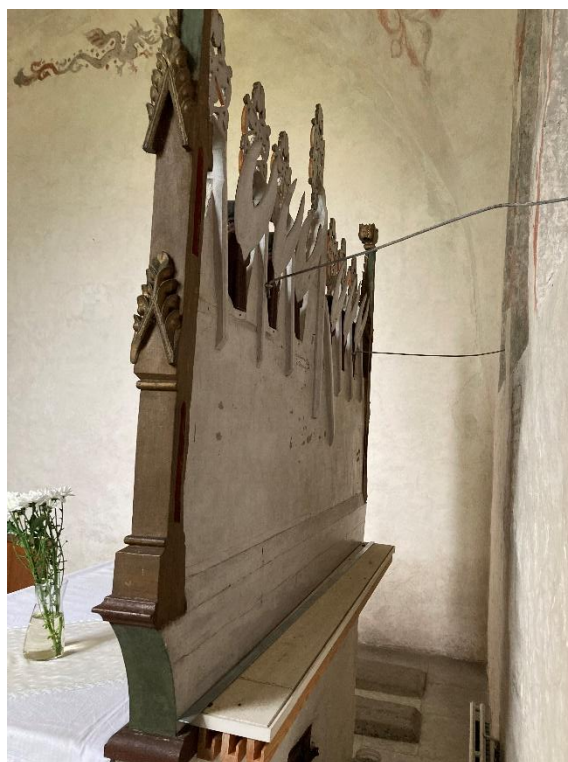
Förlaga till retabelts bågar, ristad med passare på ringkammarens västra vägg, vilket visar att det tillverkades i kyrkan, samt retabelts baksida. Foto JL 2023.
