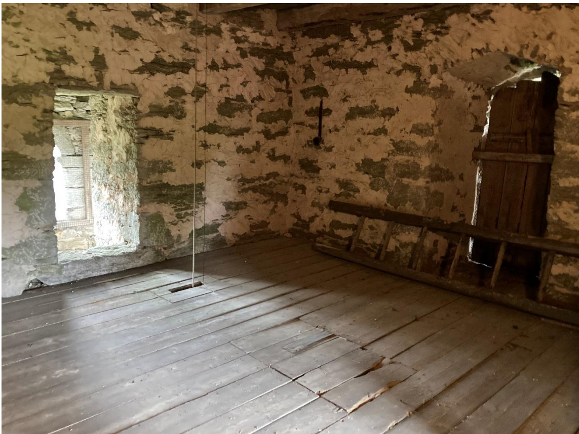
Tornets första övervåning mot sydväst. Foto JL 2023.
