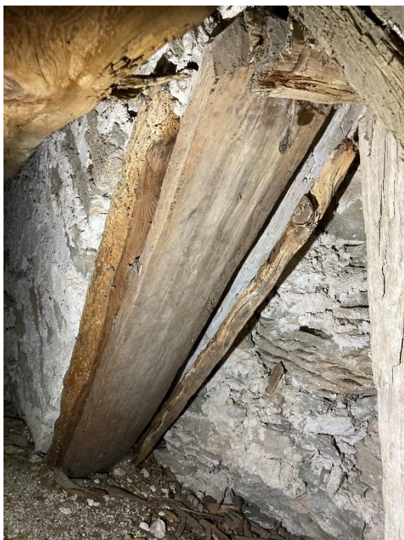
Del av avlastningsbågens träkonstruktion. Till höger tvärbjälke nära östra tornmuren med rörformat hål i muren samt nedan rester av sturk, sett mot norr. Foto JL 2023.
