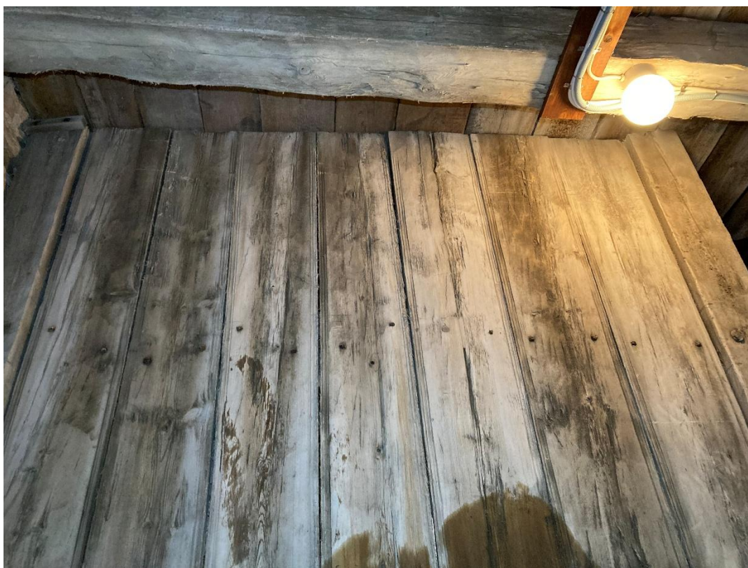
Träkammaren, övre delen av östra väggen. Panelbrädornas kanter har räfflor. Remstycke saknas som avslutning upptill. Foto JL 2023.
