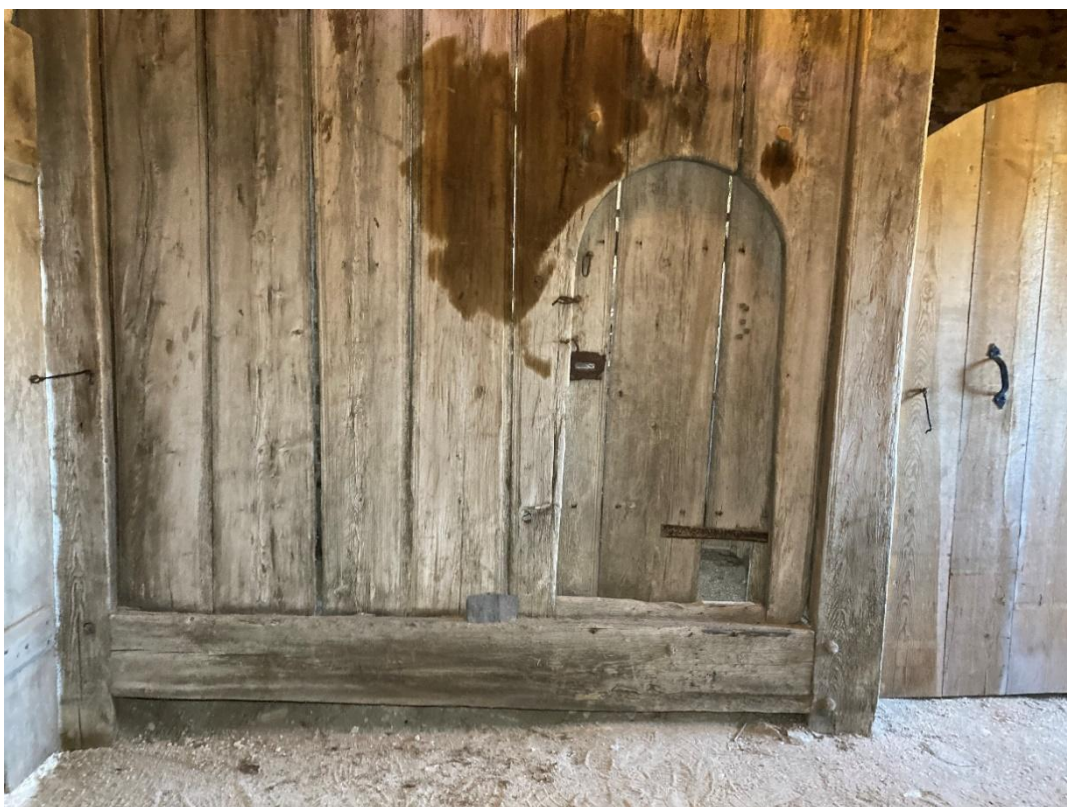
Träkammaren, nedre delen av östra väggen. Foto JL 2023.
