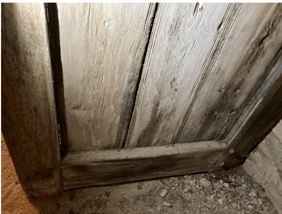
Träkammaren, nedre delen av norra väggen. Vägglankornas kanter dekorerade med räfflor. Foto JL 2023.
