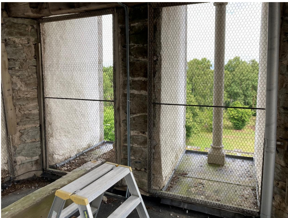
Klockvåningen mot norr. Foto JL 2023.
