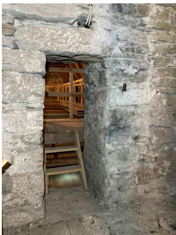
Betongbjälklag över långhusets målade träinnertak. Till höger förhöjning från 1950-talet av långhusets sidomurar. Foto JL 2023.
