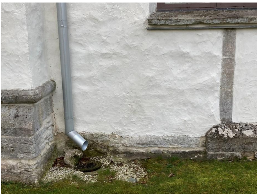
Sockeln vid korets nordvästra hörn, långhusets förlängning samt långhusets äldre del. På koret löper sockelns vulst runt hörnet men inte den skräkantade delen. Långhusets ursprungliga nordöstra hörn framträder tydligt. Till höger långhusets nordvästra fönster. Foto JL 2023.
