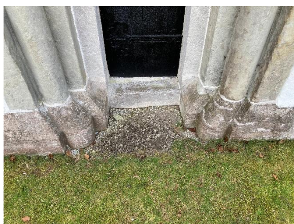
Norra långhusportalens tympanon samt dess nedre del med tröskelsten och basband. Foto JL 2023.
