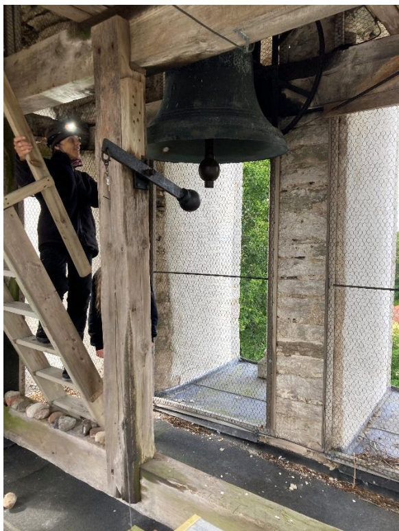
Klockvåningen mot sydväst och väster. Foto JL 2023.
