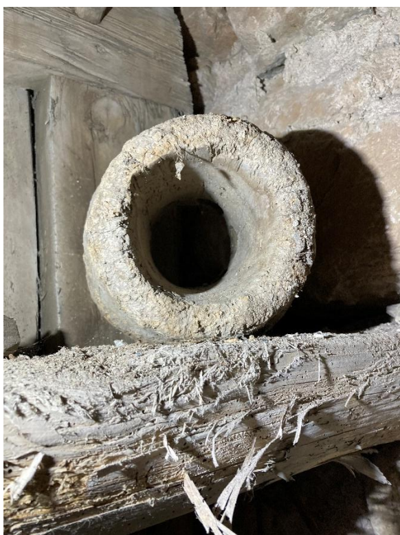
Träkammaren, löstagen sturk (träskoning av valvhål för klocklina) samt ljusglugg i tornets västra mur. Foto JL 2023.
