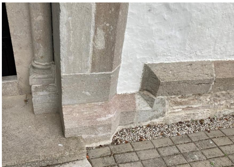
Sockelns ändrade höjd i anslutning till östra posten på långhusets sydportal. Till höger del av dörrbladet i långhusets sydportal. Foto JL 2023.
