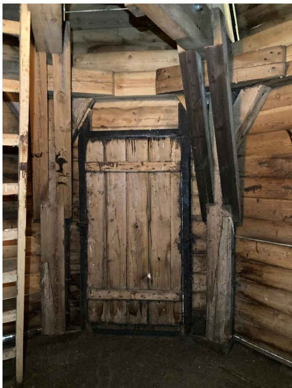
Lanterninens öppning mot sydväst, stängd och öppen. Foto JL 2023.
