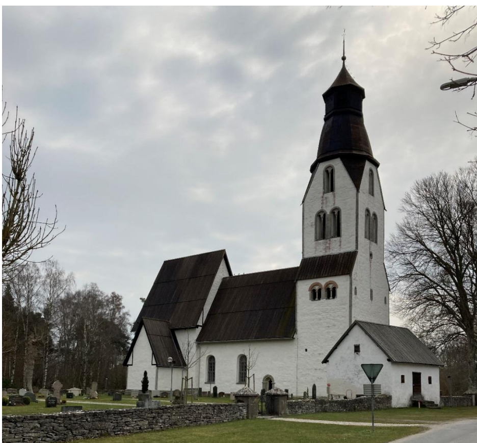
Exteriör från nordväst. Foto JL 2023.
