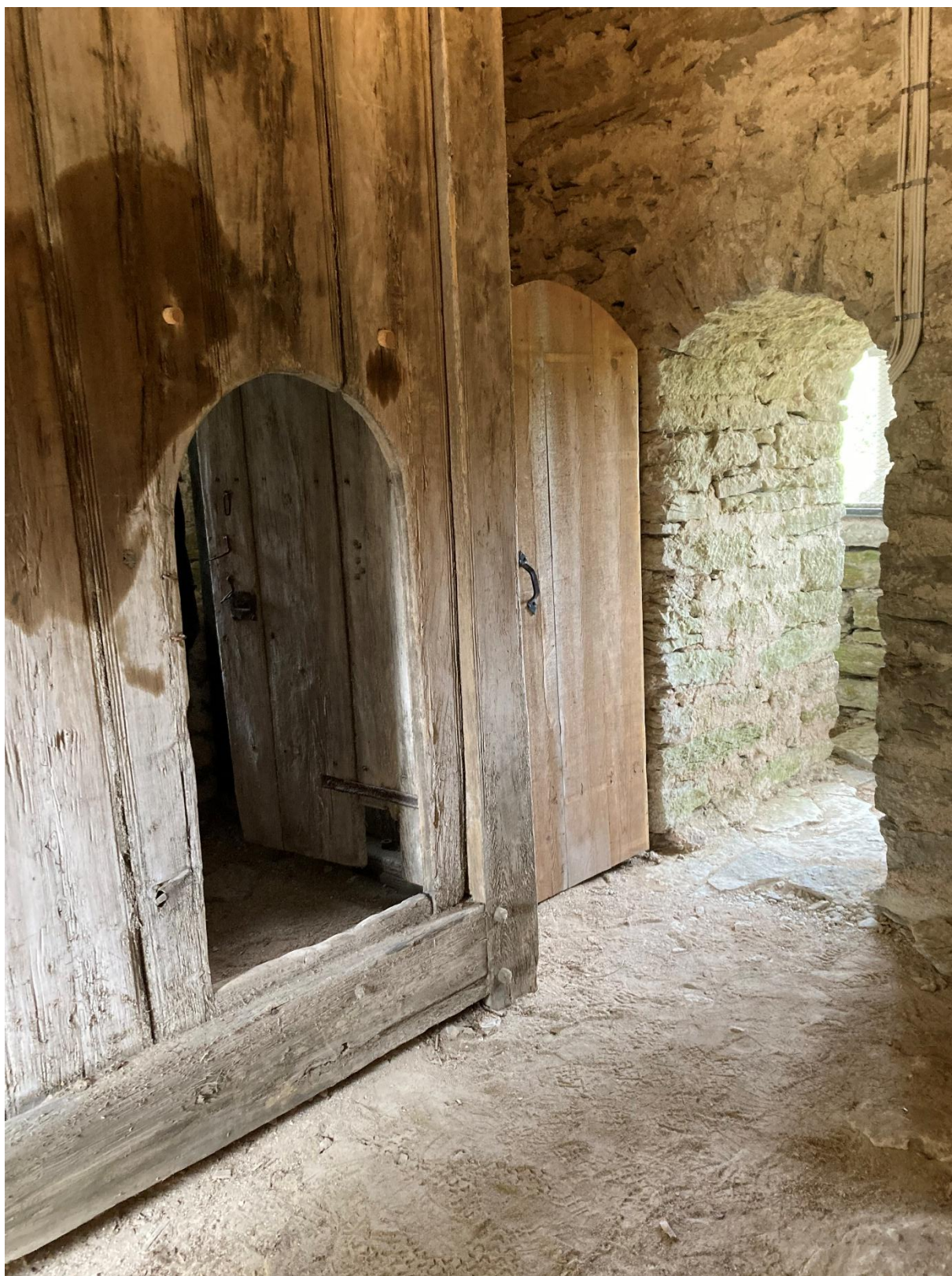
Tornets första övervåning mot nordväst med ingången från norra galleriet till höger. Foto JL 2023.
