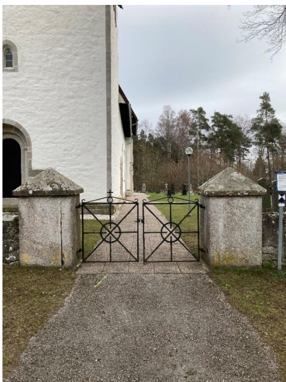
Ingången från väster med pargrindar i svartmålat smidesjärn mellan putsade fyrkantiga stolpar med pyramidformade överdelar. Foto ES 2023.
