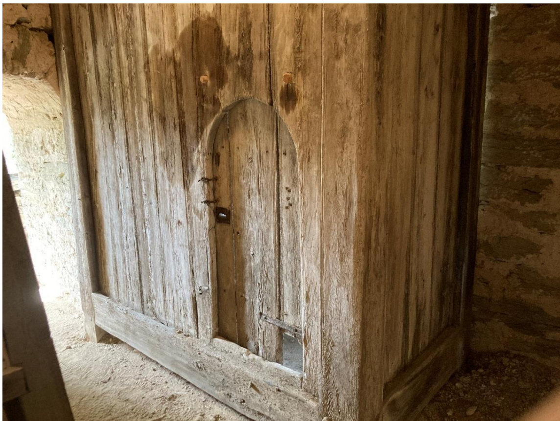
Tornets första övervåning mot sydväst med träkammare från 1200-talets mitt. Det väderbitna virket och placeringen talar för att utgångarna till sidogallerierna ursprungligen saknade dörrar. Foto JL 2023.
