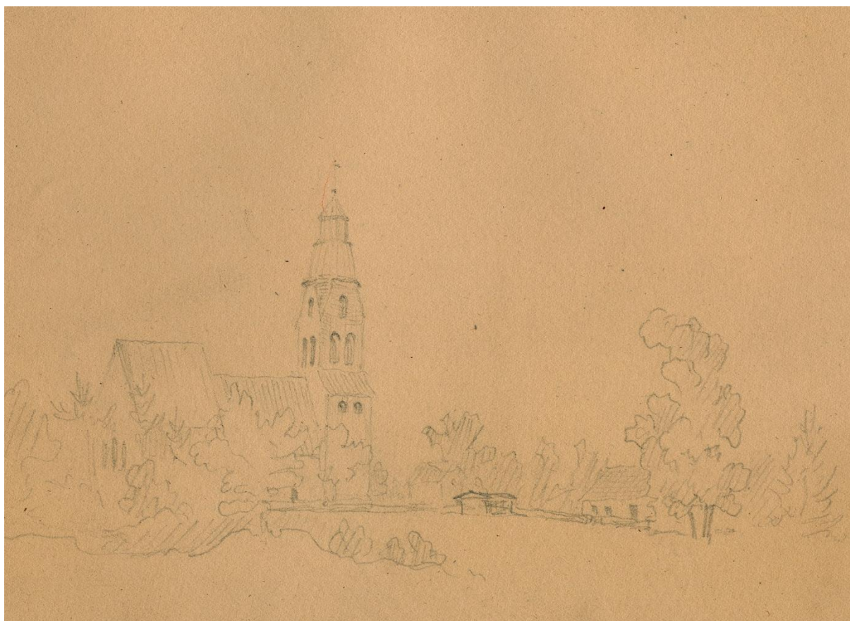
Lye kyrka tecknad av P. A. Säve 1863. Till höger syns sockenmagasinet och den mindre boden där virke och material förvarades. Alvin, UUB.
