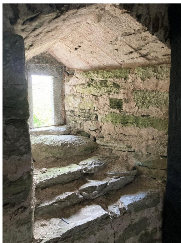
Träkammaren, löstagen sturk (träskoning av valvhål för klocklina) samt ljusglugg i tornets västra mur. Foto JL 2023.
