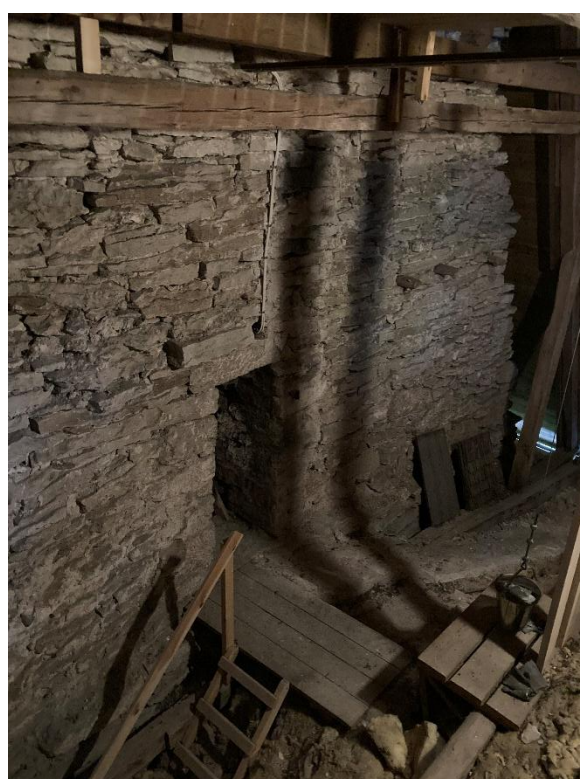
Betongbjälklag över långhusets målade träinnertak. Till höger förhöjning från 1950-talet av långhusets sidomurar. Foto JL 2023.
