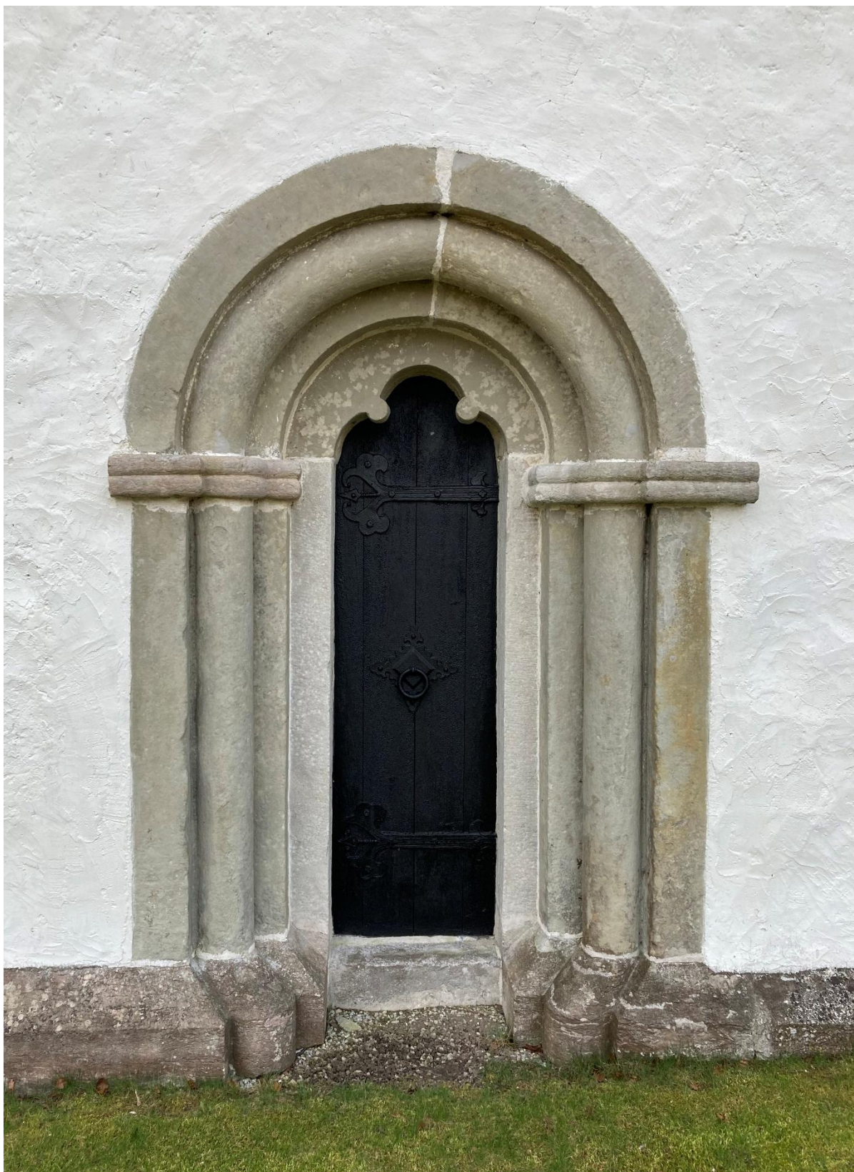
Långhusets norra portal. Foto JL 2023.
