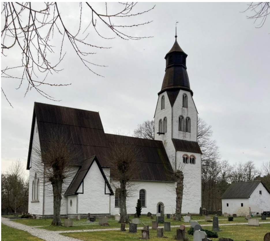
Exteriör från nordöst. Foto JL 2023.
