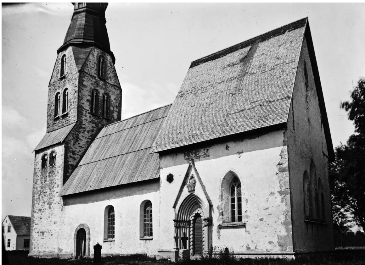
Exteriör från sydöst. Foto Olof Sörling, troligen från 1890-talets mitt, ATA. Sedan föregående bild har korets södra fall fått spåntak.
