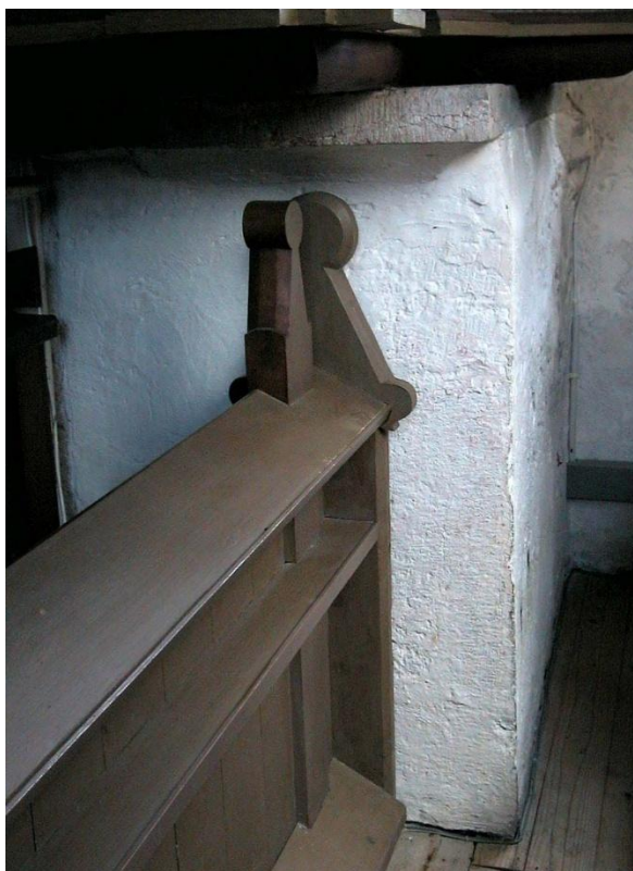
Predikstolens fundament, delvis bestående av ett murat medeltida sidoaltare. Till höger dörr till predikstolstrappan. Foto Bo-Göran Kristoffersson 2003-2004, Visby stift.
