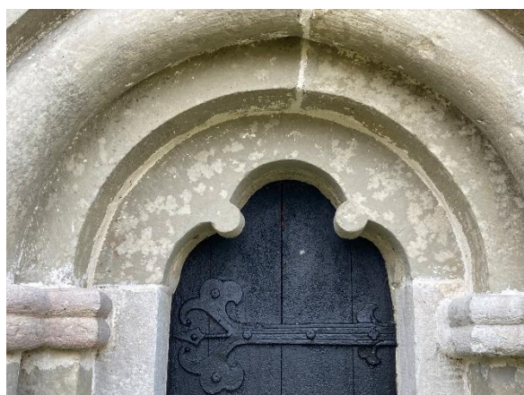
Norra långhusportalens tympanon samt dess nedre del med tröskelsten och basband. Foto JL 2023.
