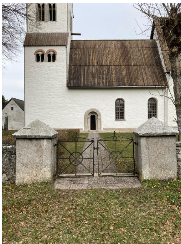
Ingången från söder med liknande utformning som ingången i väster. Pargrindar i svartmålat smidesjärn mellan putsade fyrkantiga stolpar med pyramidformade överdelar. Foto ES 2023.
