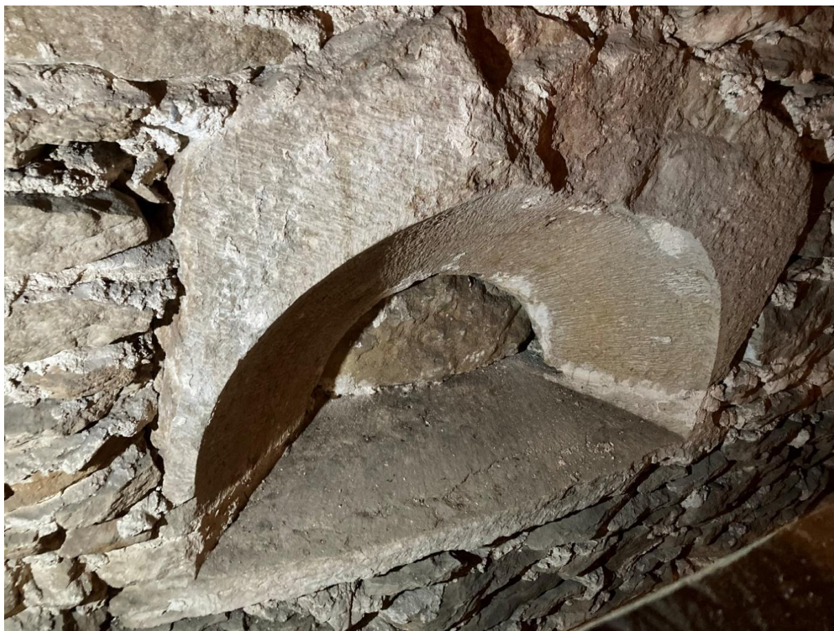
Igensatt ljusglugg gjord av krön och botten till romansk fönsteromfattning vars svagt framskjutna form visar att den har suttit i en absid i det romanska koret. Foto JL 2023.
