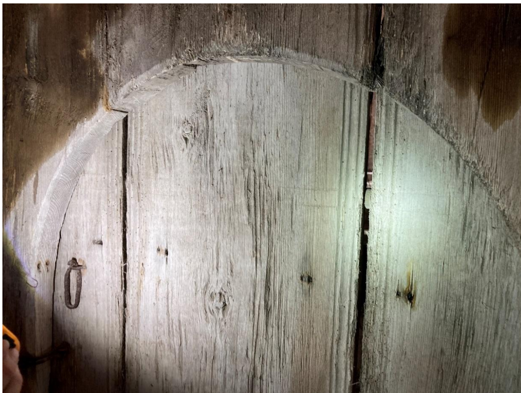
Träkammaren, dörröppningens övre del. Dymlingarnas lägen markerade med ristning. Foto JL 2023.
