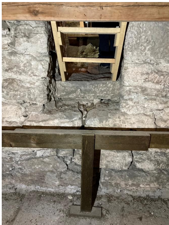
Betongbjälklag över långhusets målade träinnertak. Till höger förhöjning från 1950-talet av långhusets sidomurar. Foto JL 2023.
